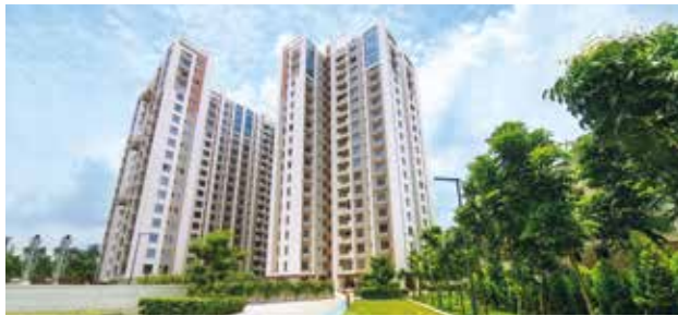
Ozone, South EM Bypass
